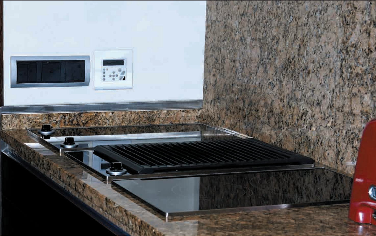
A konyhában a világításkapcsolók mellett kapott helyet a lokális kezelési és többszobás rendszervezérlési funkciókat irányító Russound UNO-S2 falı vezérlőpanel
